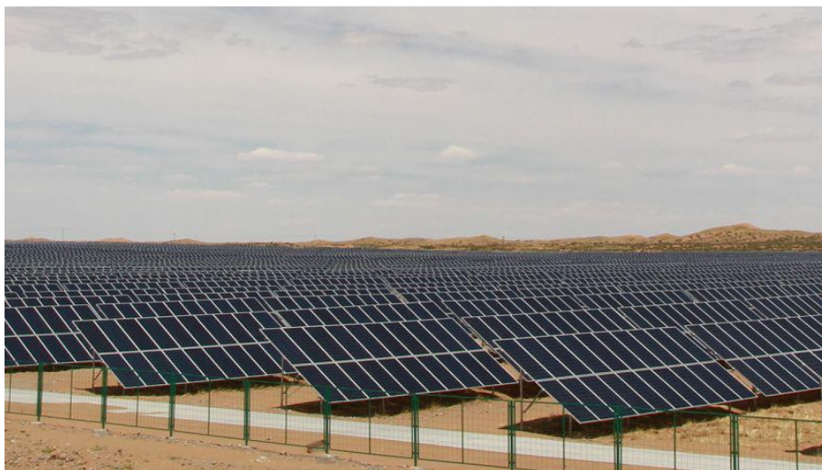
图2-9 泰丰新能源生产性实训基地
